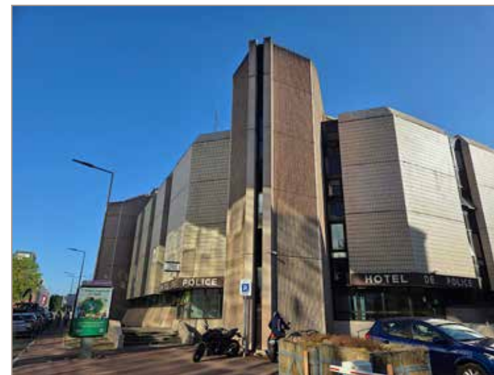
Hôtel de Police de Cergy - Siège de la DIPN 95 et de la CPN Cergy
